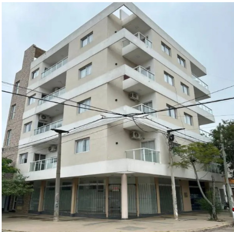
Chacabuco N° 707, Sáenz Peña. Lugar donde se llevará adelante la obra.
